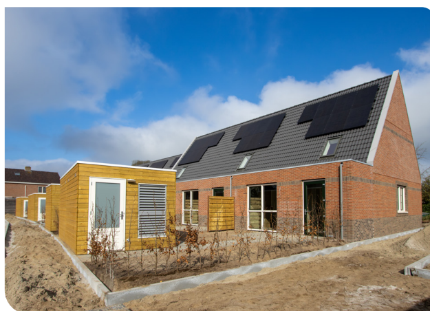
Afbeelding 3. Berging nieuwbouwproject Borculo - buitenluchtroosters onder elkaar
