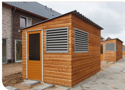
Afbeelding 6. Berging met WG buitenluchtroosters naast elkaar geplaatst
