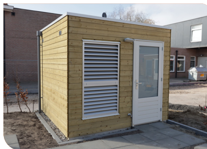
Afbeelding 5. Berging met WG buitenluchtroosters boven elkaar geplaatst
