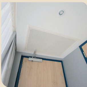
Figuur 4. WISL - Waterloo inspectieluik Holiday Inn
